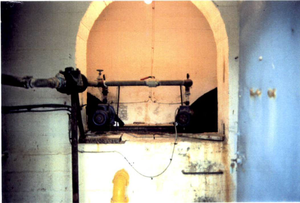
FOTO 6: Interior del depósito regulador.
