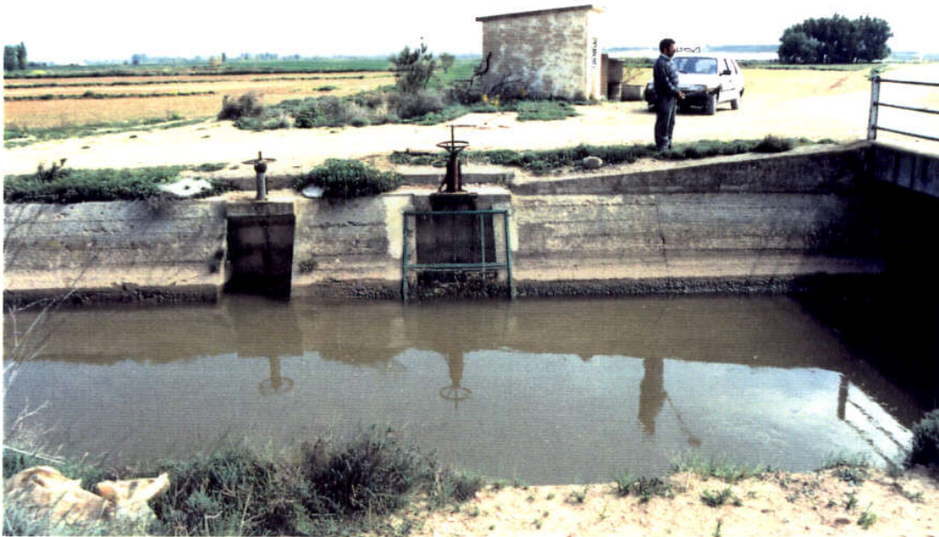
FOTO 1: Toma de aguas del Canal de Lodosa.
